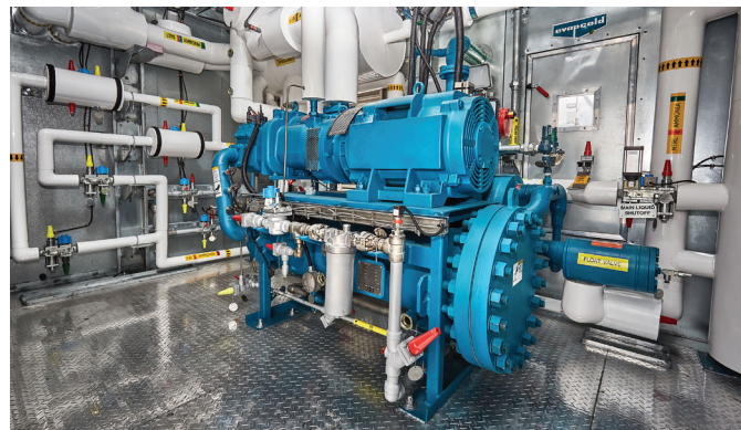
Cuarto de máquinas con amoníaco de baja carga LCR-P-W
