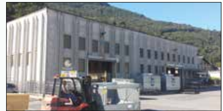
EVAPCO Europe, S.r.l., Sondrio, Italy
