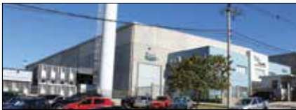
EVAPCO Brasil Equipamentos Industriais Ltda., São Paulo, Brazil
