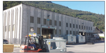
EVAPCO Europe, S.r.l., Sondrio, Italy
